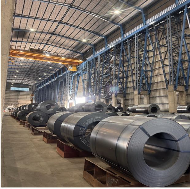
ตำแหน่งห้องควบคุมเครนยก
