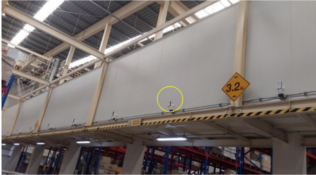
การติดตั้งอุปกรณ์แองเคอร์ UWB บนแนวคาน
