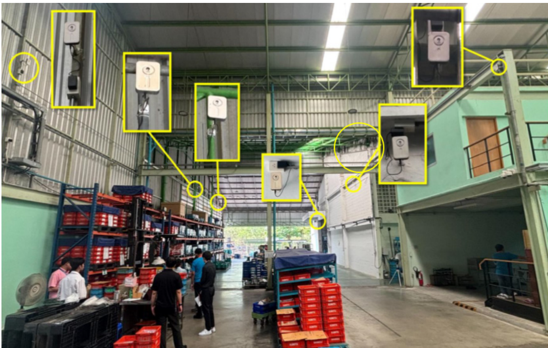
การติดตั้งอุปกรณ์แองเคอร์ UWB บนแนวคาน
