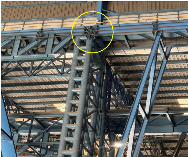
การติดตั้งอุปกรณ์แองเคอร์ UWB ที่ความสูง 30 เมตร ใต้หลังคา
